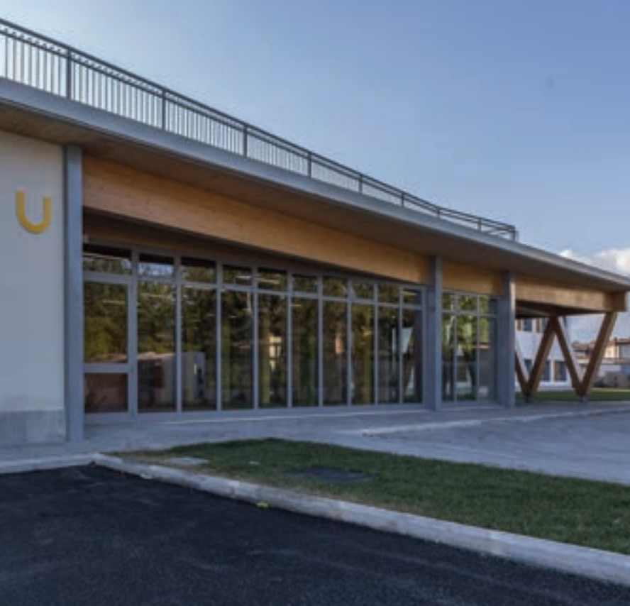
AVEZZANO (L'AQUILA) Scuola primaria "Agostino Persia", 2017
