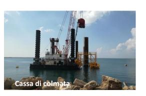
Interventi di dragaggio di 2,3 Mm³ di sedimenti in area molo Polisettoriale e per la realizzazione di un primo lotto della cassa di colmata. L'intervento prevede il dragaggio della darsena, del cerchio di evoluzione e dell'imboccatura del molo polisettoriale e la realizzazione di un primo lotto funzionale della cassa di colmata per una capacità di circa 2,3Mm³, in ampliamento al V sporgente del Porto di Taranto, in cui saranno conferiti i sedimenti dragati.
