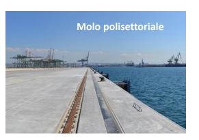
Riqualificazione del molo Polisettoriale ed ammodernamento della banchina di ormeggio. L'intervento ha consentito il consolidamento della banchina di ormeggio mediante la realizzazione di opere strutturali finalizzate a consentire l'approfondimento dei fondali, realizzare le vie di corsa in grado di servire le gru di banchina di ultima generazione, aggiornare le reti di utenza quali l'impianto di drenaggio e l'alimentazione elettrica in Media Tensione.
