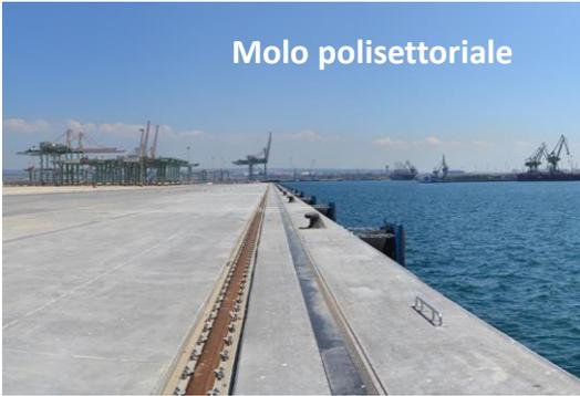
**Riqualificazione del molo Polisettoriale ed ammodernamento della banchina di ormeggio.** L'intervento ha consentito il consolidamento della banchina di ormeggio mediante la realizzazione di opere strutturali finalizzate a consentire l'approfondimento dei fondali, realizzare le vie di corsa in grado di servire le gru di banchina di ultima generazione, aggiornare le reti di utenza quali l'impianto di drenaggio e l'alimentazione elettrica in Media Tensione.
