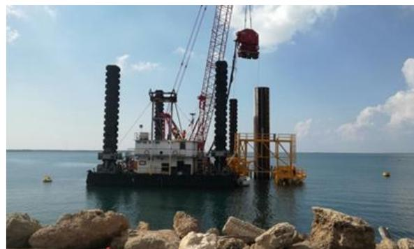
*Figura 5.4. Intervento per il dragaggio e per la realizzazione di un primo lotto della cassa di colmata*
