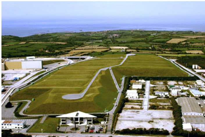
Francia Deposito di La Manche (Normandia) Completo
