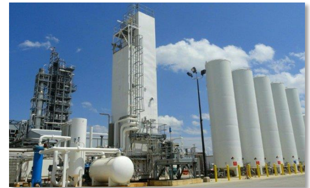
Impianto di frazionamento aria
