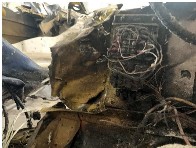
Foto: 45: i relè che comandano l'attuatore del pitch trim prima della rimozione dal relitto.
