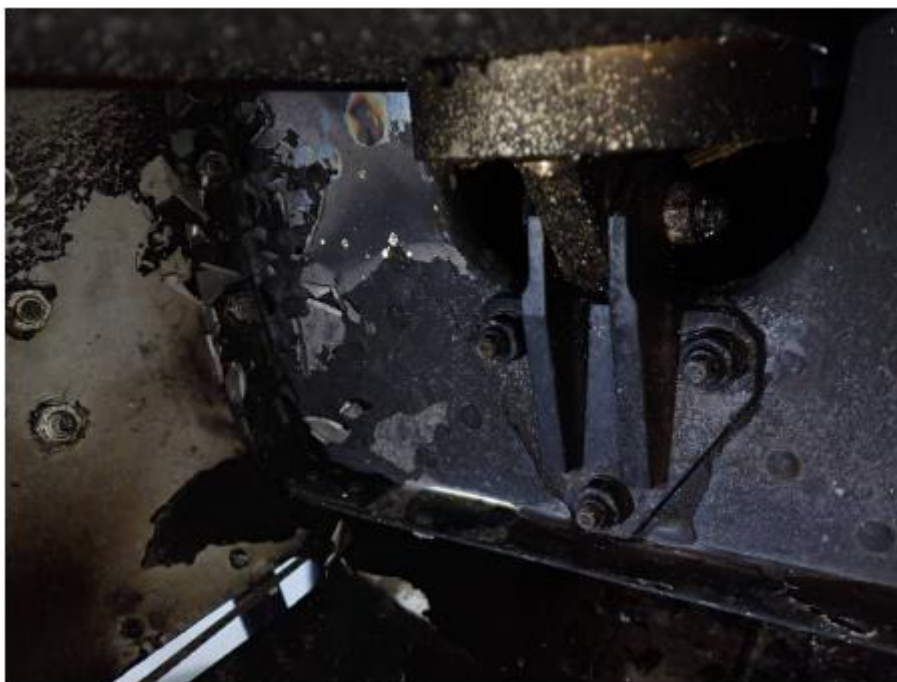
Foto 36: punto di attacco inferiore dell'attuatore alla fusoliera.
